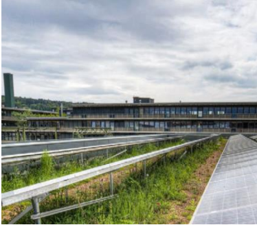
Dach des ewz-Unterwerks Oerlikon mit Photovoltaik und Begrünung
