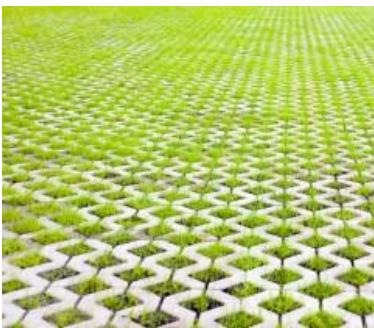
Rasengitter ermöglichen Versickerung und Verdunstung
